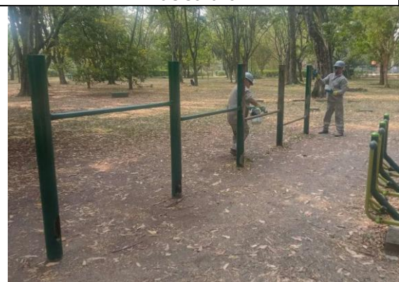
Figura 182: Manutenção academia pista de cooper
