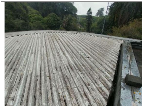
Figura 184: Manutenção Preventiva – Limpeza do telhado Hub Esportivo
