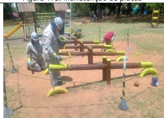
Figura 175: Manutenção dos equipamentos - Playground
