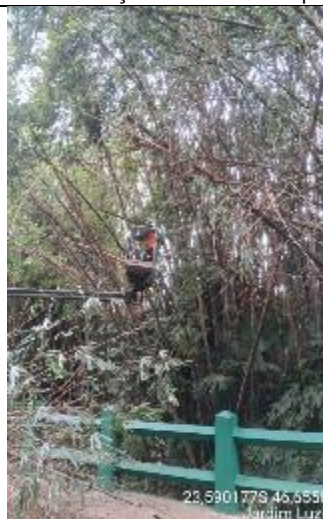
Figura 97: Remoção de bambu quebrado
