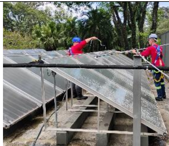
Figura 178: Manutenção preventiva de placas solares
