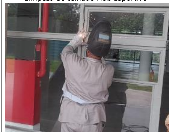
Figura 186: Manutenção de esquadrias
