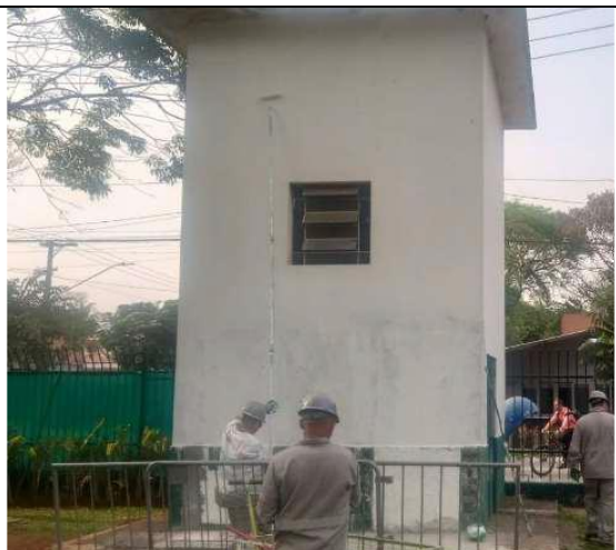
Figura 181: Manutenção de pintura
