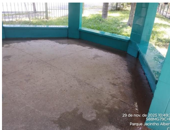
Figura 35: Limpeza dos bancos
