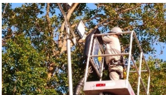
Figura 67: Ajustes de refletores das quadras de tênis
