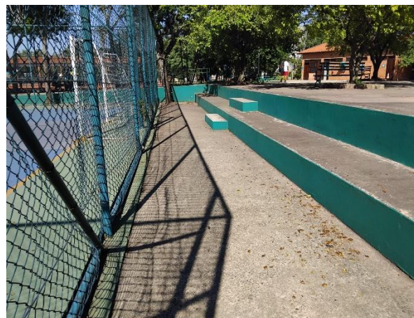
Figura 168: Limpeza da área da Quadra Poliesportiva
