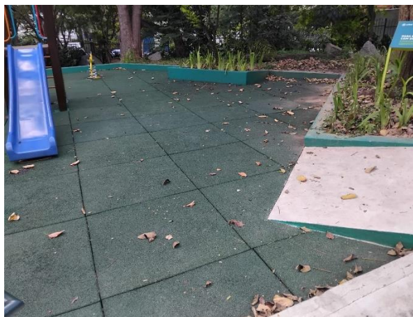
Figura 48: Limpeza do Parquinho Inferior - Antes
