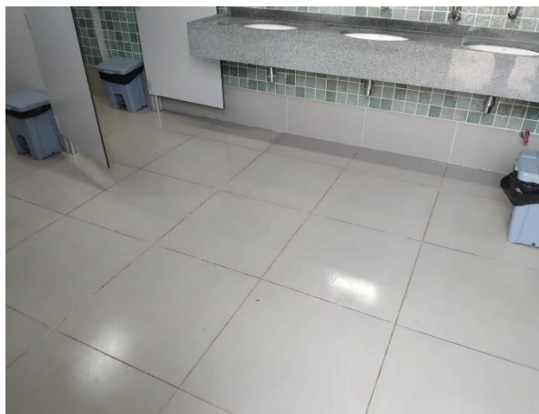
Figura 63: Limpeza do banheiro feminino
