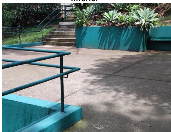
Figura 31: Limpeza do Parquinho Inferior
