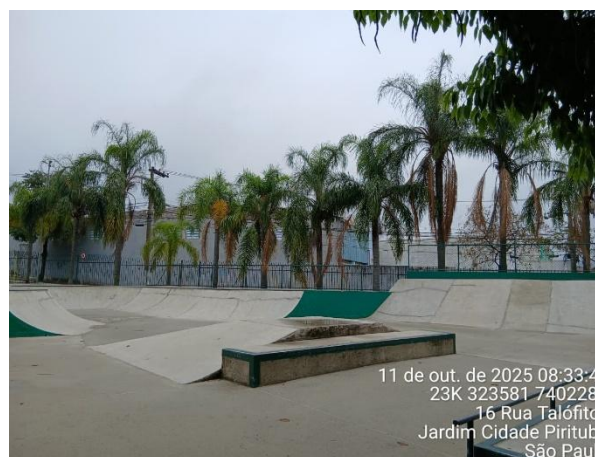
Figura 39: Limpeza da área da Pista de Skate - Depois
