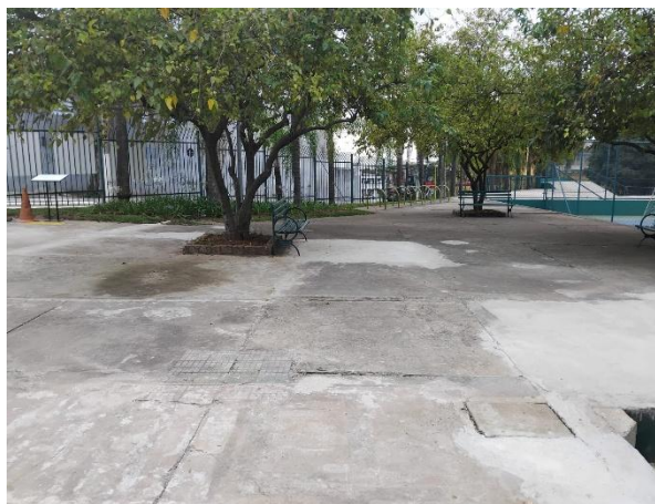
Figura 11: Limpeza da área da Quadra Poliesportiva
