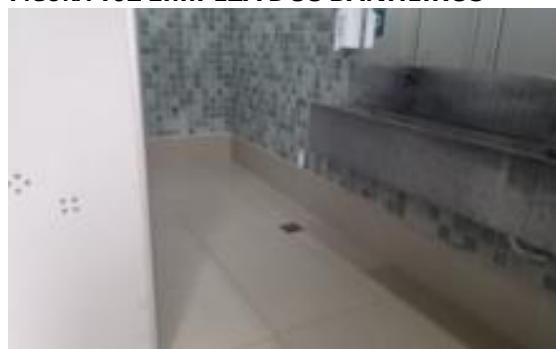
FIGURA 104 LIMPEZA DOS BANHEIROS
