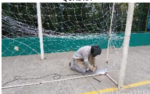
FIGURA 168 SOLDA NAS TRAVES DO GOL
