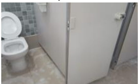
FIGURA 101 LIMPEZA DOS BANHEIROS
