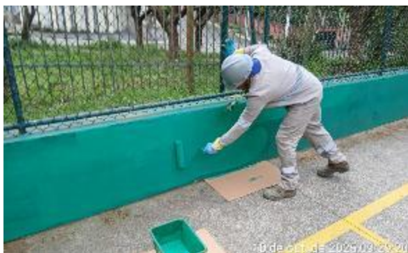
FIGURA 163 PINTURA DAS MURETAS DA QUADRA
