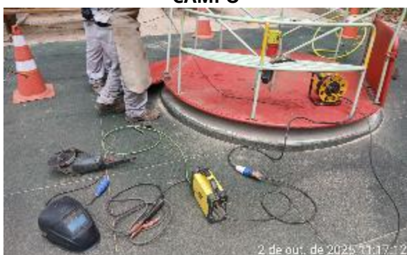
FIGURA 175 SOLDA NO BALANÇO PCD
