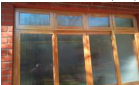
FIGURA 131 LIMPEZA DAS JANELAS
