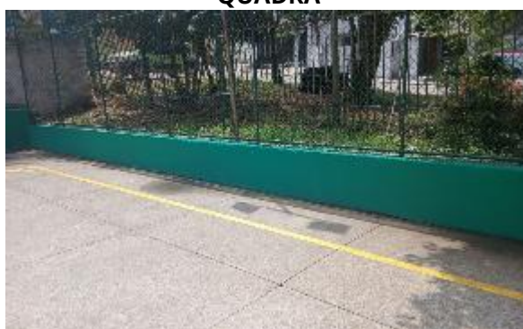
FIGURA 166 PINTURA DAS MURETAS DA QUADRA
