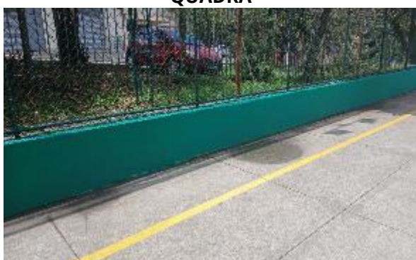
FIGURA 165 PINTURA DAS MURETAS DA QUADRA
