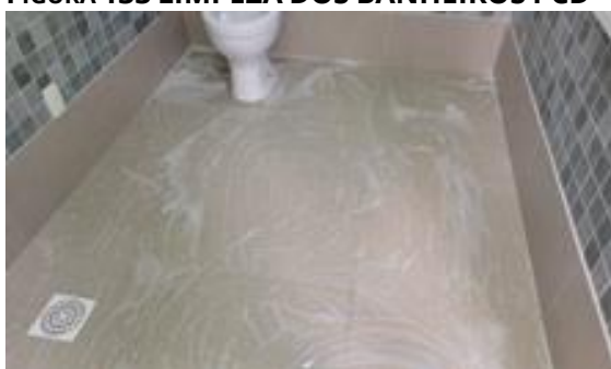
FIGURA 135 LIMPEZA DOS BANHEIROS PCD
