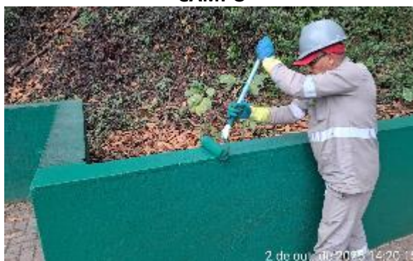
FIGURA 174 PINTURA DAS MURETAS DO CAMPO
