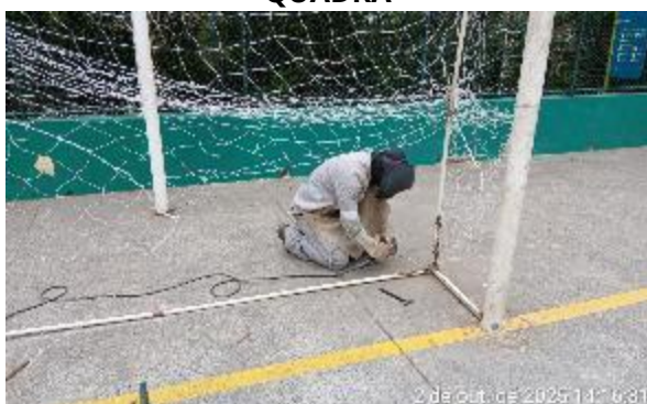
FIGURA 167 SOLDA NAS TRAVES DO GOL
