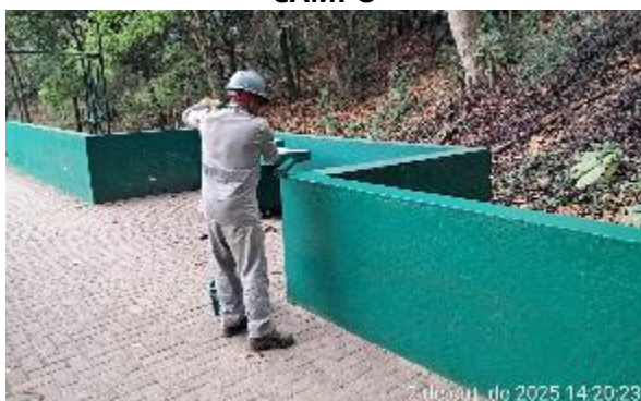
FIGURA 173 PINTURA DAS MURETAS DO CAMPO
