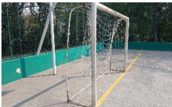
FIGURA 169 SOLDA NAS TRAVES DO GOL
