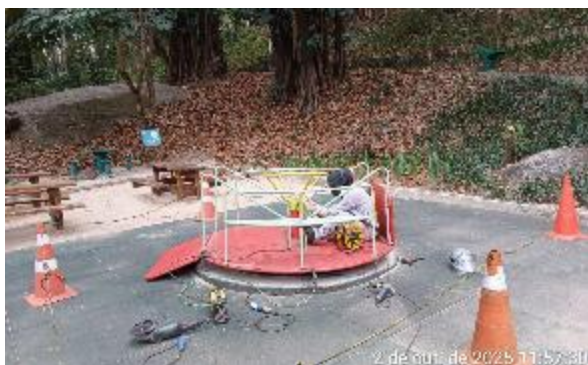
FIGURA 177 SOLDA NO BALANÇO PCD
