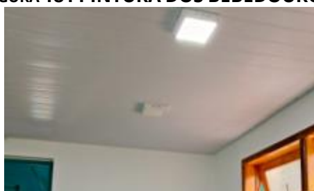
FIGURA 183 SUBSTITUIÇÃO DE LÂMPADAS DANIFICADAS
