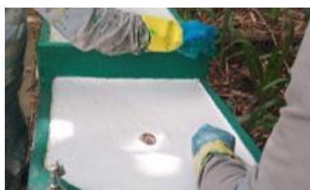
FIGURA 179 PINTURA DOS BEBEDOUROS
