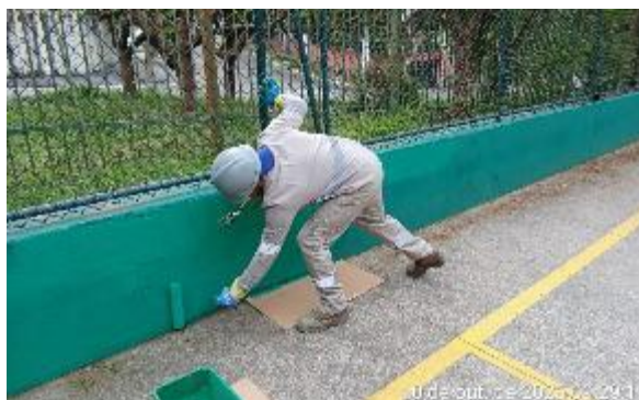
FIGURA 164 PINTURA DAS MURETAS DA QUADRA
