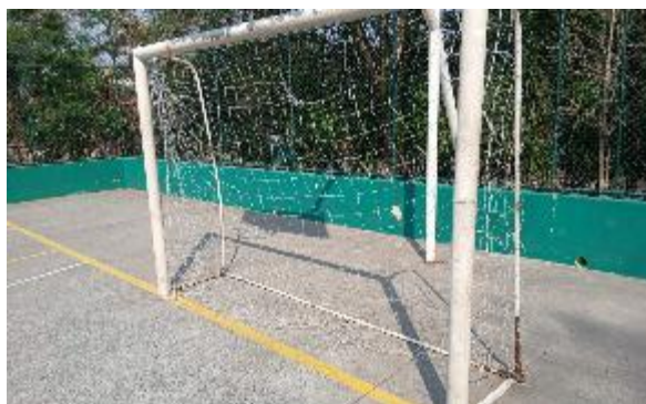
FIGURA 170 SOLDA NAS TRAVES DO GOL
