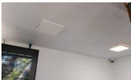
FIGURA 185 SUBSTITUIÇÃO DE LÂMPADAS DANIFICADAS
